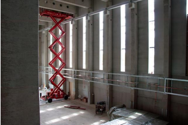
Neue Gießereihalle im Rohbau, Blick von der 2. Etage in die Halle, Foto: © sis/utg
